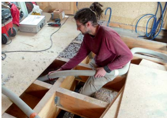
Pose de ouate de cellulose sous plancher.
